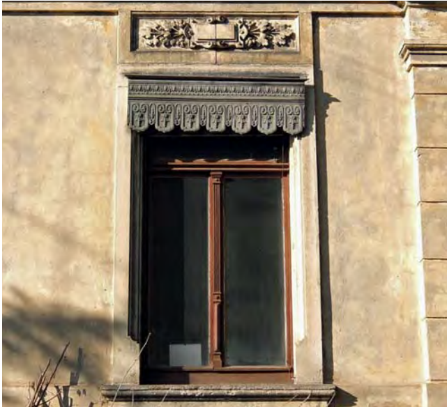
T- oder „Galgen“-fenster: Ostseite
