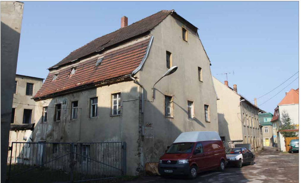
Abbildung 2: Gebäude Mühlgraben 15 vor dem Abriss (Foto: LfA Sachsen)
