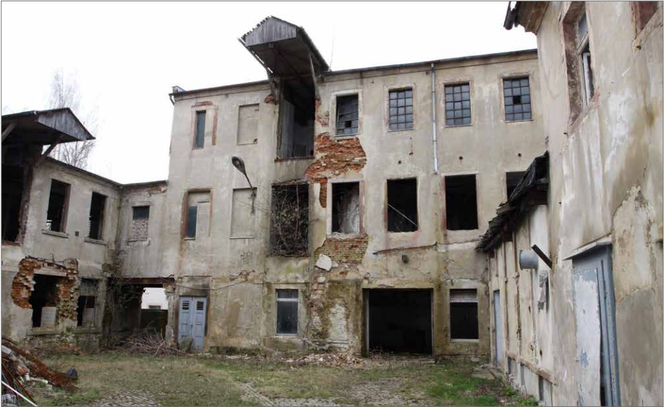
Abbildung 1: Innenhof der „Alten Reißerei“ vor dem Abriss (Foto: LfA Sachsen)
