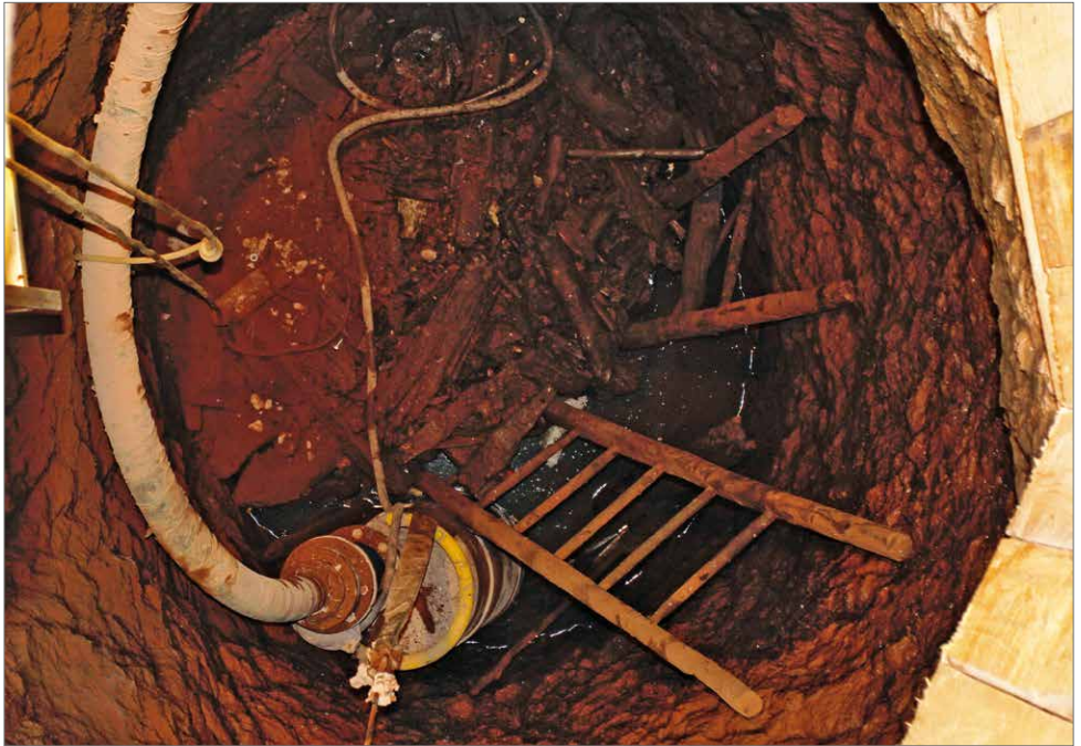
Abbildung 4: Blick in den Brunnenschacht auf die beiden Leitern („Fahrten“), hier noch in der Verfüllung stehend (Foto: LfA Sachsen)
