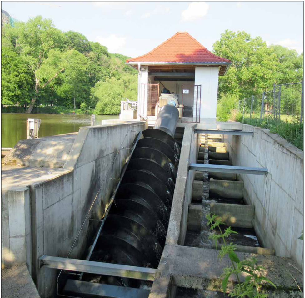
Abbildung 30: Die Neubautätigkeit am linken Flussufer in einer Aufnahme von 2021 (Fischstiege)
