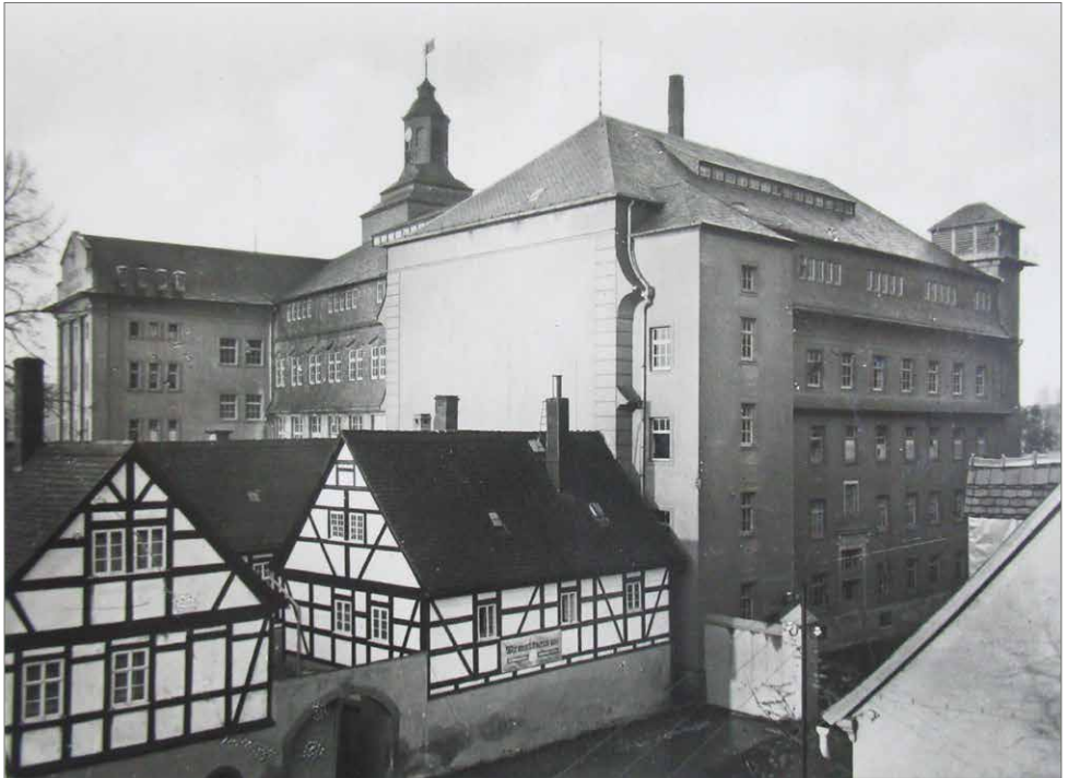
Abbildung 15: Gesamtaufnahme der Baulichkeiten von Mühle und Fabrik; undatierte Aufnahme (um 1940) eines unbekanntes Fotografen
