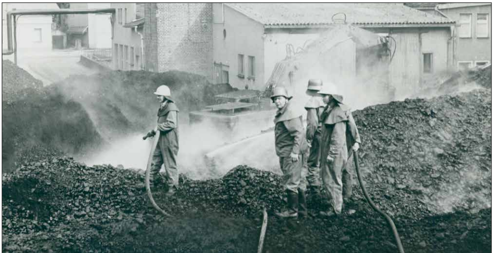
Abbildung 17: Bekämpfung eines Schwelbrandes durch die Werksfeuerwehr in den späten 1980er Jahren. Die Braunkohle wurde bei Anlieferung in großen Mengen in den Innenhof gekippt, bevor sie dann in das Kohlelager gebracht wurde.
