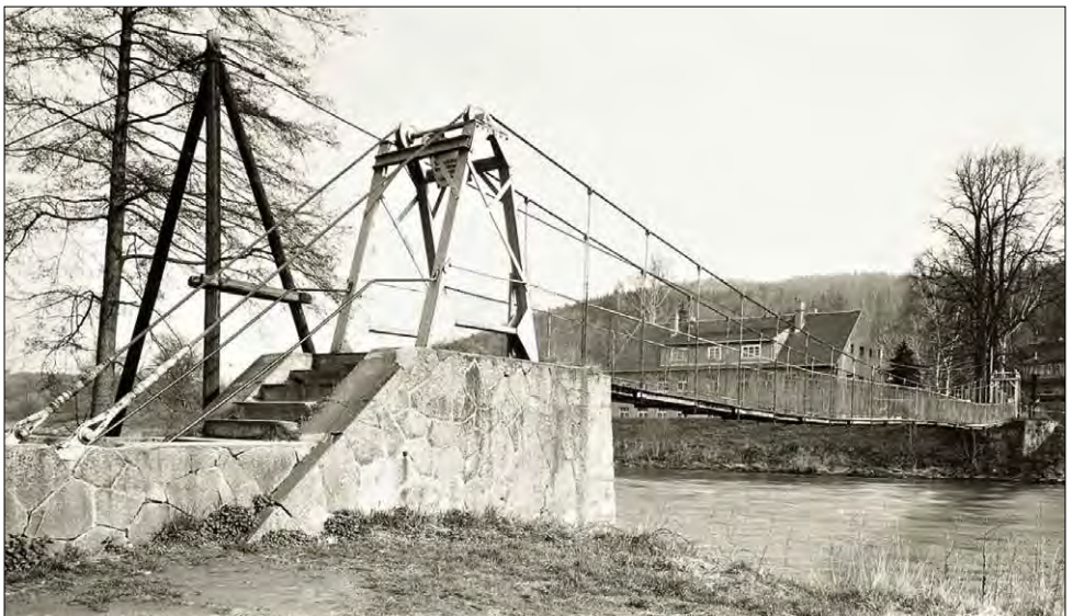
Abbildung 33: Zustand der Brücke im Jahre 1985
