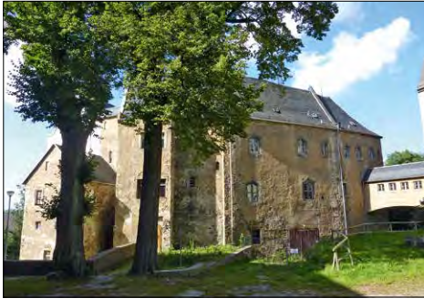
Abbildung 36: Das Schloss vor Beginn der aktuellen Sanierungsarbeiten, aufgenommen im Juni 2018
