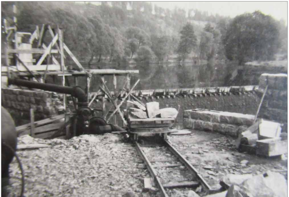
Abbildung 14: Bauarbeiten zur Errichtung einer neuen Wehranlage sowie der zugehörigen Uferstützmauern; undatierte Aufnahme (1953?) eines unbekanntem Fotografen
