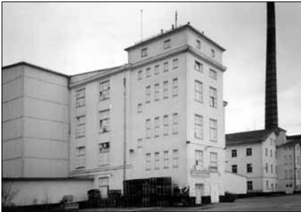
Stahlbetonbau (sog. Neubau) im Jahre 1995 (Bild 10)
