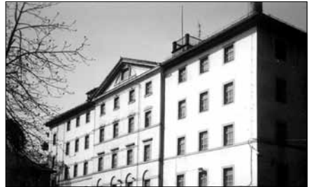
Hauptgebäude der ehemaligen Spinnerei im Jahre 1995 (Bild 8)
