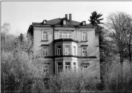
Stabil, doch in die Jahre gekommen zeigte sich das Gebäude vor Beginn der Rekonstruktion (Bild 12)
