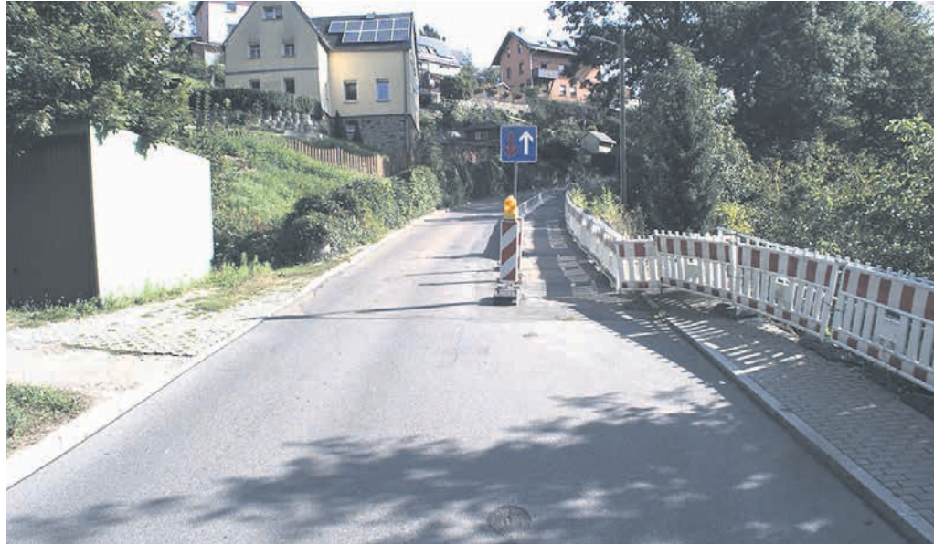
Gegenwärtig wird am Vergabeverfahren zum Ausbau der Waldheimer Straße in Mittweida gearbeitet. Foto: Landratsamt
