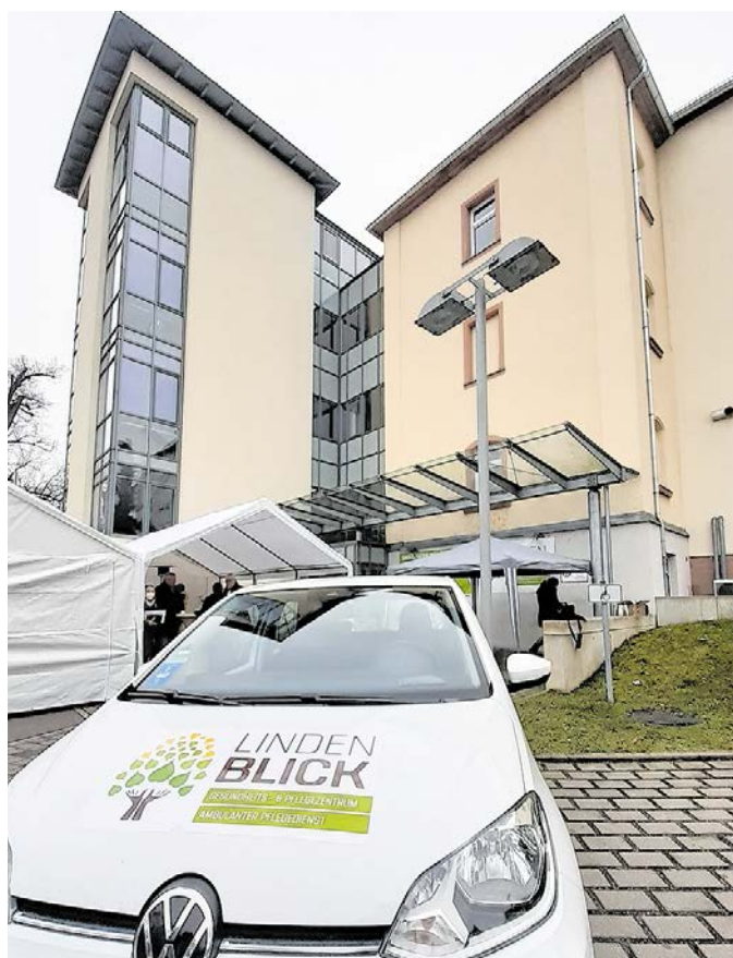
Im Frühjahr 2023 soll der Umbau des ehemaligen Krankenhauses in Rochlitz beendet sein. Foto: Landratsamt
